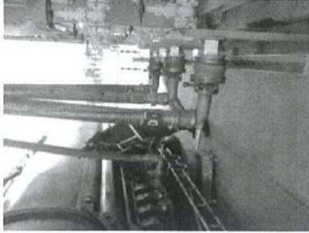
รูปแสดงการนำ Loading Arm มาต่อเข้ากับขอรรับน้ำมัน
