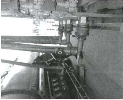
รูปแสดงการนำ Loading Arm มาต่อกับช่องรับน้ำมัน
